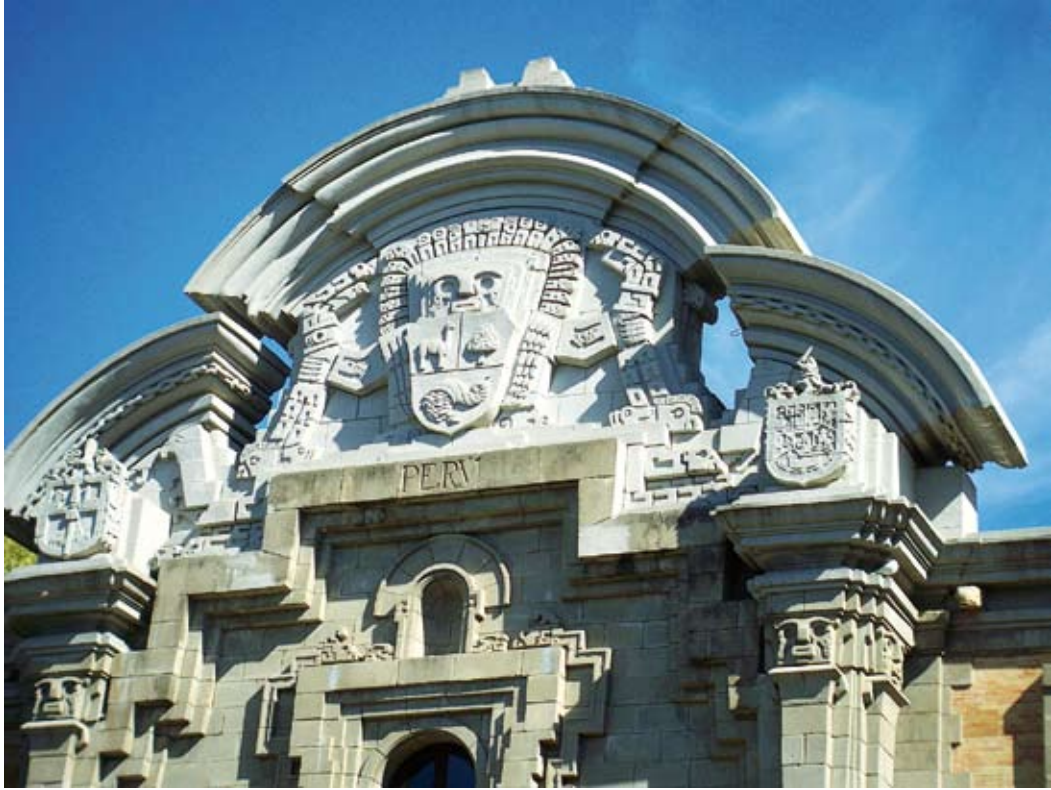
Manuel Piqueras Cotelí. Detalle de la fachada principal del Pabellón del Perú. Exposición Iberoamericana de Sevilla, 1929. (Foto: Rodrigo Gutiérrez Viñuales).
