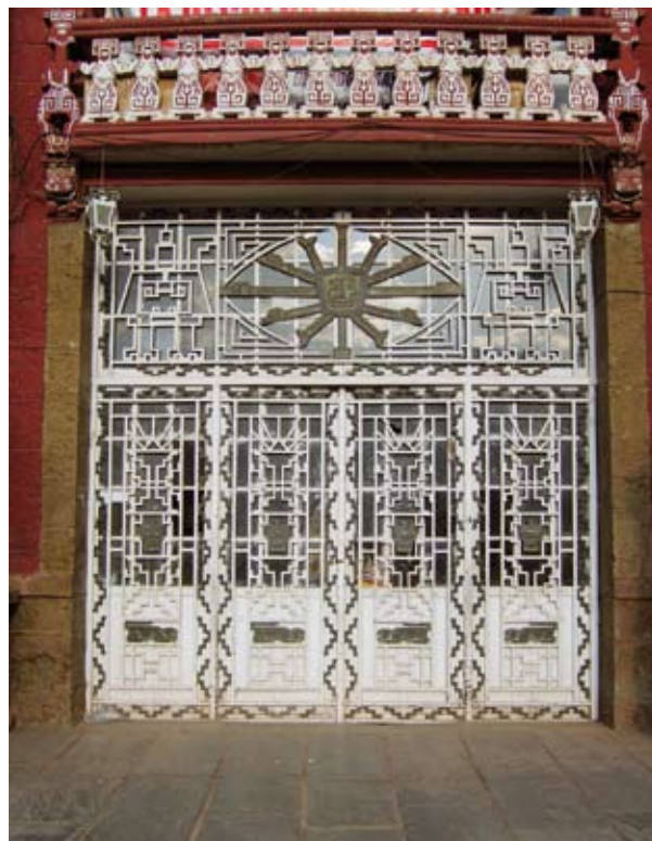
Puerta de ingreso del Hospital Antonio Lorena (1928-1932), Cuzco. Carpintería de hierro forjado con motivos incanistas y aplicaciones en bronce (Foto: Rodrigo Gutiérrez Viñuales).
