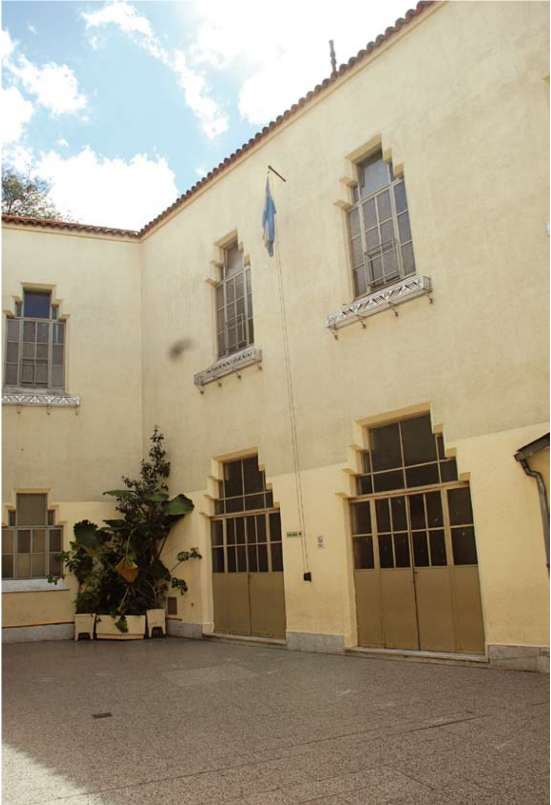
Alberto Gelly Cantilo. Patio interior de la Escuela "Joaquín B. González" (1932). Buenos Aires. (Foto: Martín Gutiérrez Viñuales).
