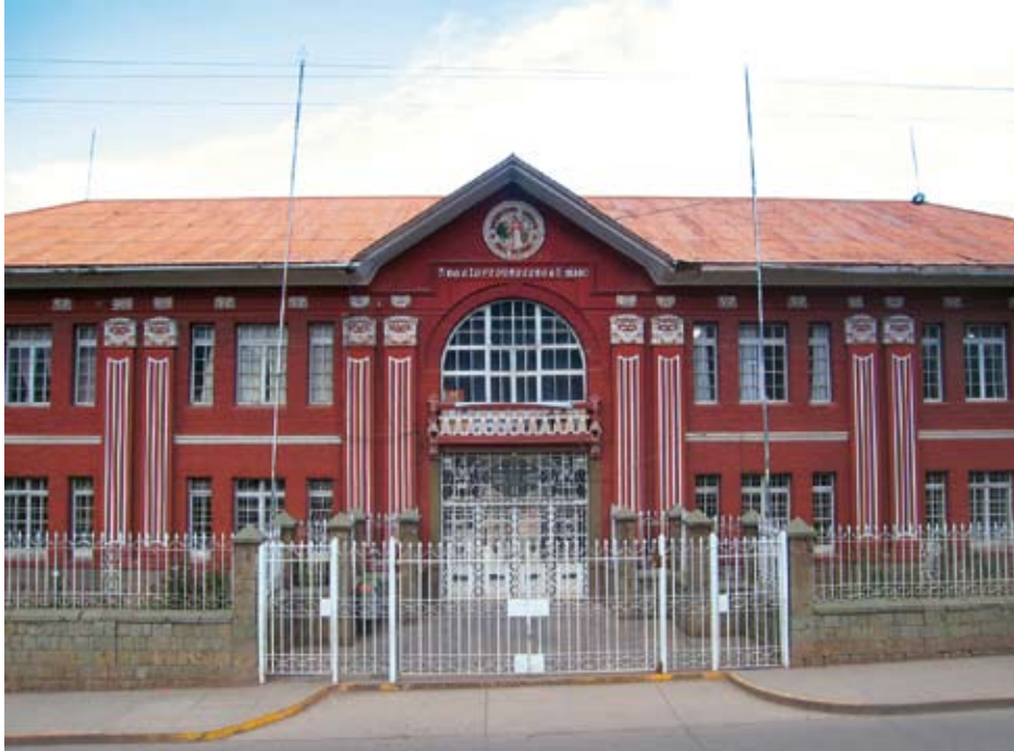
Fachada del Hospital Antonio Lorena (1928-1932), Cuzco. (Foto: Elizabeth Kuon).
